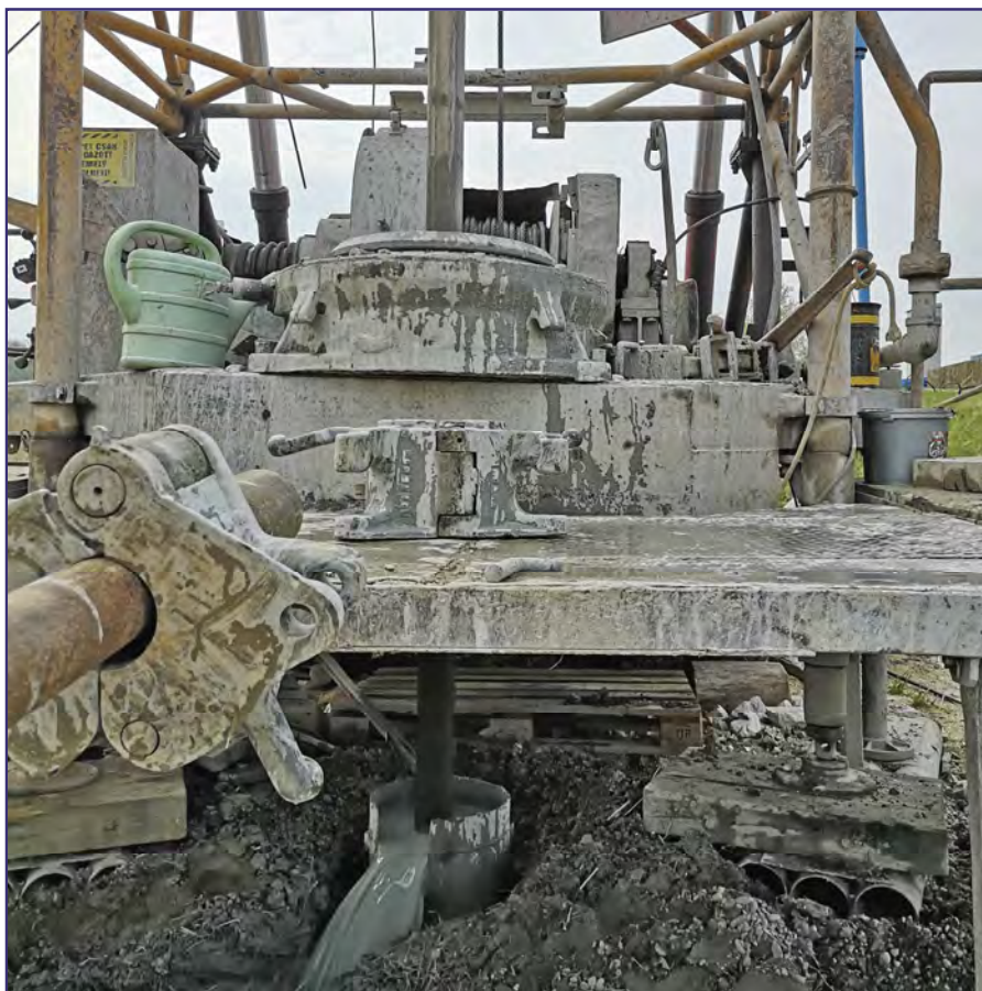
Kútfúrás előkészítése a keleti vízbázison
