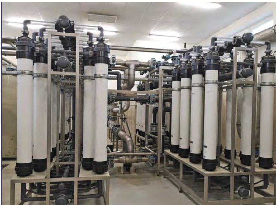
A jövő útja: víztisztítás korszerű ultraszűrőkkel a zalaegerszegi nyugati víztisztítóban
